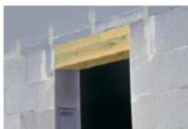
◀ **Pour les coffres de volets roulants** apparents qui ne sont pas en éléments de maçonnerie, la préparation (ex. encollage, pose d'armature, renforts de joints) doit être effectuée préalablement à l'enduisage par le poseur du coffre en conformité à l'Avis Technique du fabricant, Document Technique d'Application ou équivalent.
