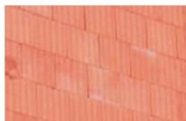
◀ **La brique :** Les maçonneries de briques de terre cuite doivent être arrosées à l'avancement, moins d'une demi-heure avant l'enduisage. Cet arrosage est indépendant des conditions atmosphériques et de la rétention d'eau du mortier frais. Si les conditions de chantier font que ce délai est dépassé, un nouvel arrosage est nécessaire.
